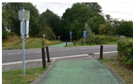
Traversée de la route entre Thimister & Clermont, site à sécuriser ... ?
