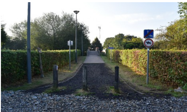
Passerelle surplombant la N3, entre la L38 et la piscine, le stade, les commerces ...
