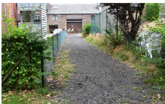
Thimister, accès vers rue de la Station, accès à rendre plus praticable ... ?
